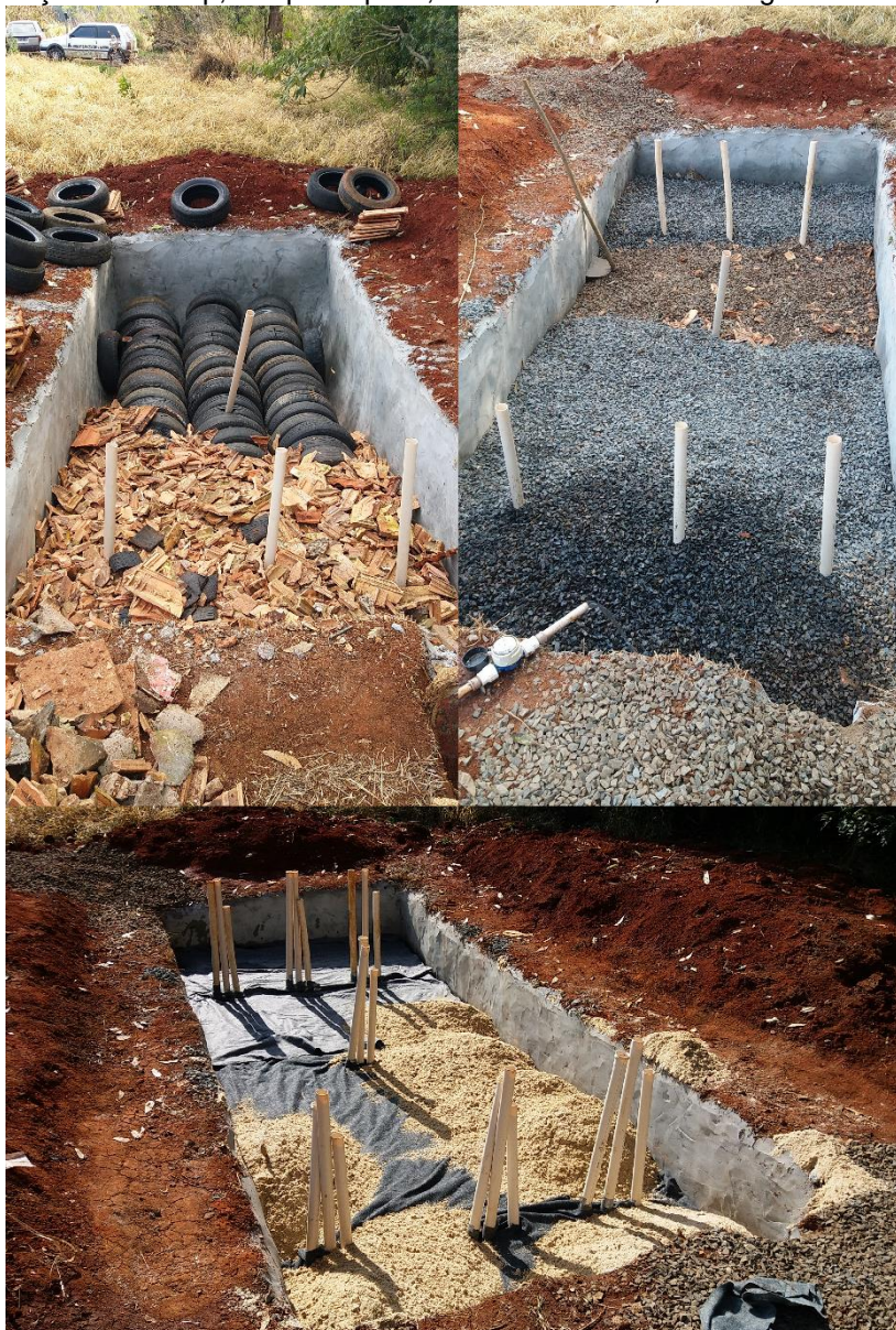
Figura 4: Implantação do TEvap, tanque séptico, camada de brita, manta geotêxtil e camada de areia
