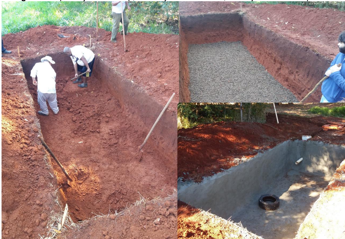
Figura 3: Implantação do TEvap, escavação da trincheira, execução do fundo e paredes
