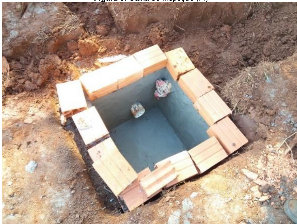
Figura 8: Caixa de Inspeção (Pi)
