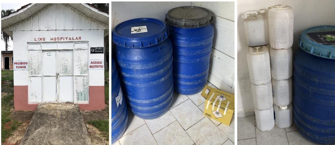
Figura 31 - Armazenamento externo dos Grupos A, B e E, Prudentópolis (PR), 2020
