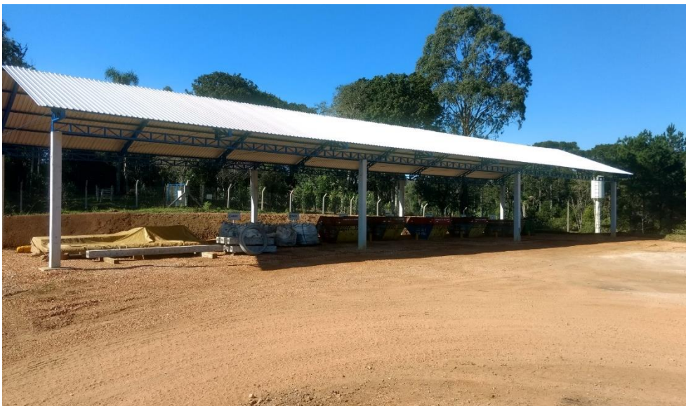
Figura 07 – Área de armazenamento dos materiais proibitivos ao processo de reciclagem de RCC classe A
