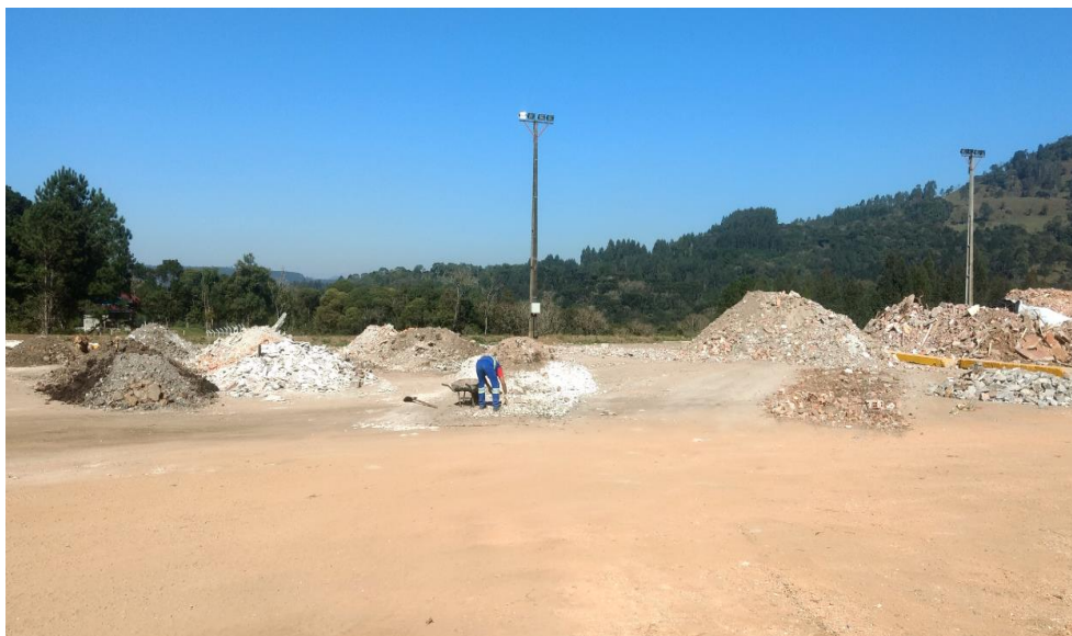
Figura 06 – Área de triagem de RCC
