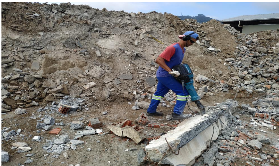
Figura 08 – Utilização do martelo demolidor
